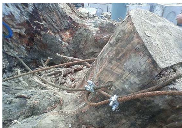
Figura 23: Particolare del passaggio attraverso il tronco del cavo in acciaio di legatura tra le ceppaie.
