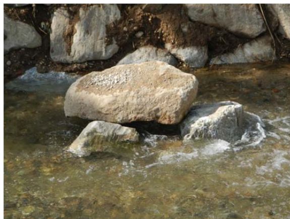
Figura 19. Esempio realizzativo di massi sottosponda al piede di una scarpa.
