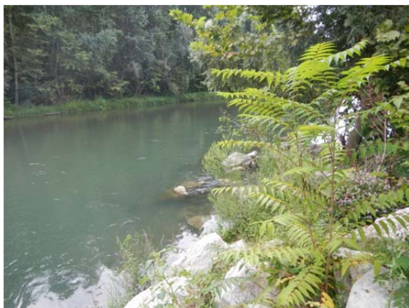
Figura 18. Esempio di massi sottosponda presso il tratto terminale del Ramo centrale dell'Adda.
