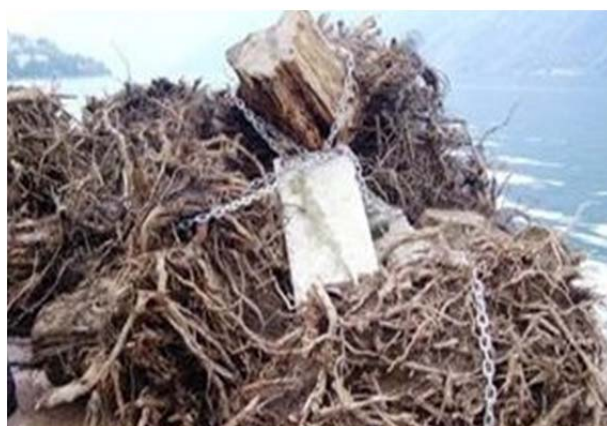
Figura 22: Esempio di ceppaie in gruppo pronte per la posa.
